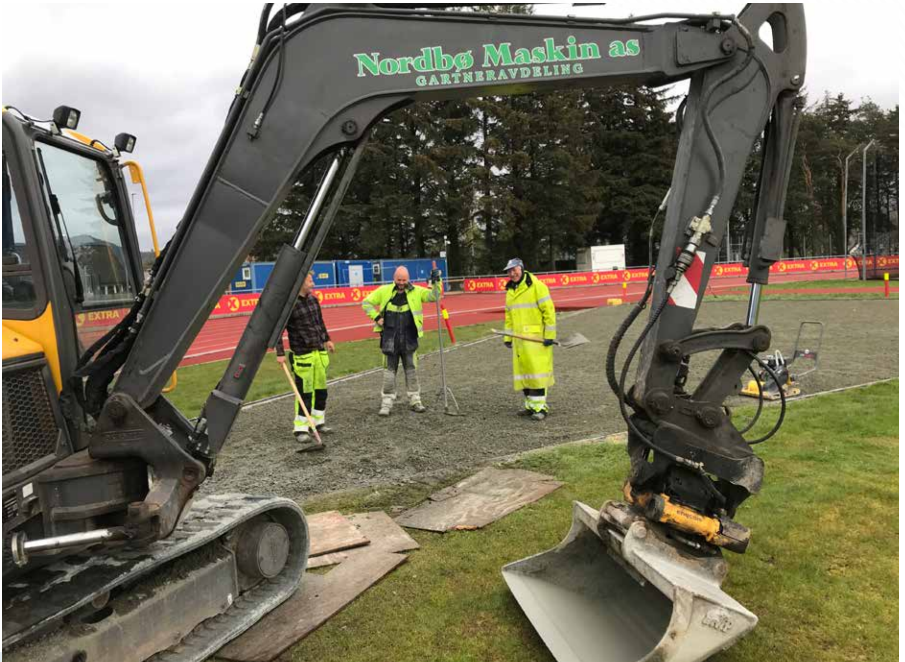
Det pågår en betydelig oppgradering av Sandnes idrettspark i disse dager. Kulesektoren må forlenges med to meter for å kunne ta imot de lange kastene under mesterskapet.
